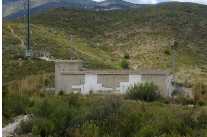
Imagen 26. Depósito Abastecimiento Cerro Ocará
